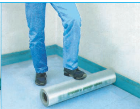
Etendue de la feuille protectrice en PE, épaisseur minimum 0,15 mm, en superposition aux bords.
