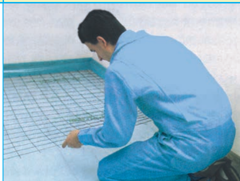
Etendue de la grille métallique du support, superposant les feuilles minimum 10 cm
