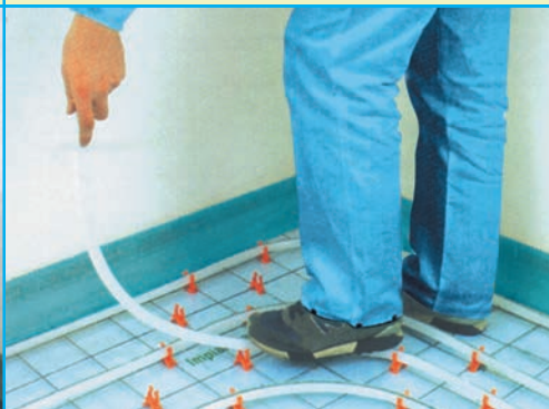
Mise en place du tube sur les agrafes précédemment fixées sur la grille métallique.
