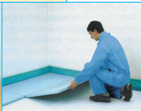
Pose des plaques isolantes.
